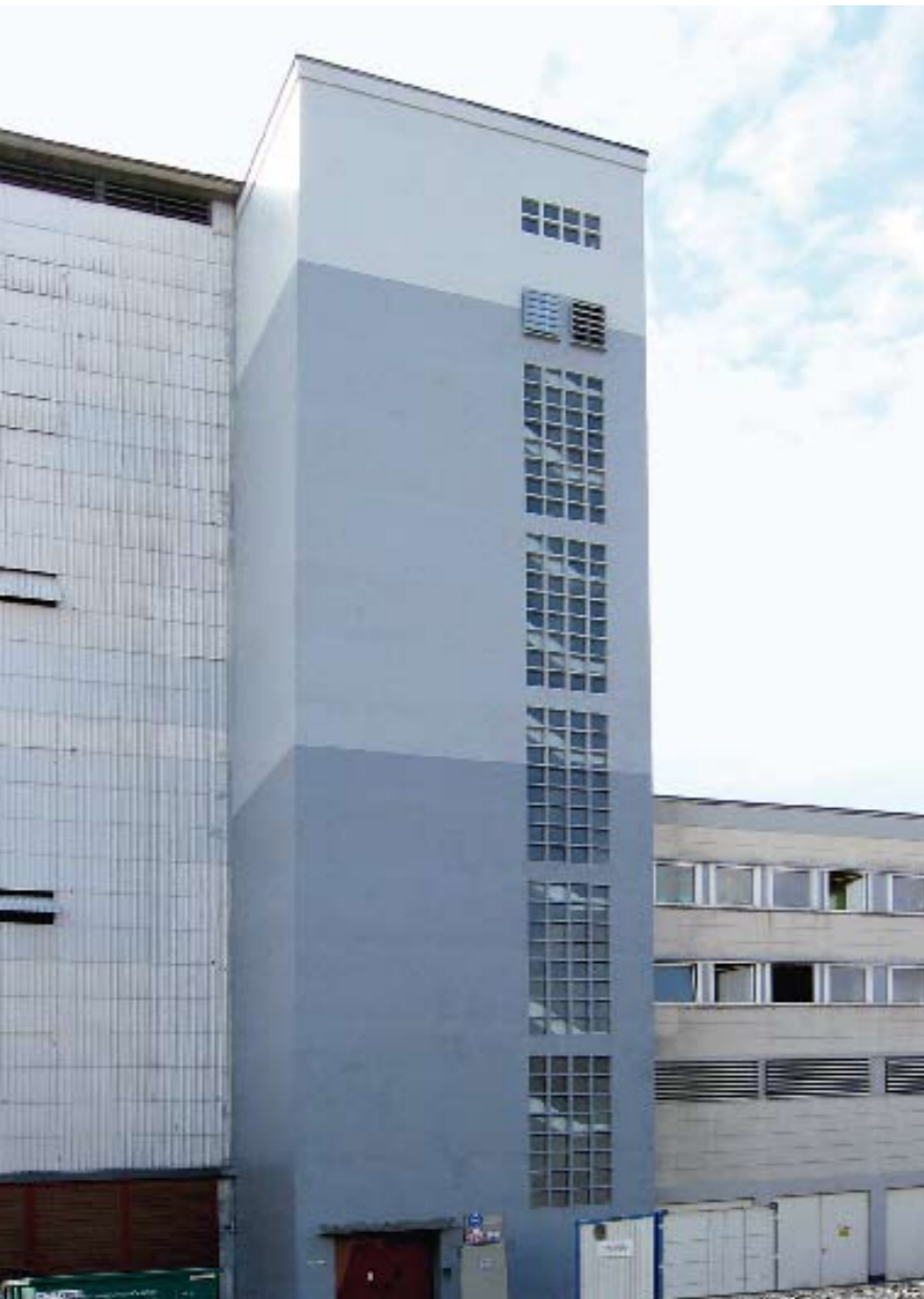
Auf Jahre geschützt: Der Beton des Treppenhausturms einer Industrieanlage auf dem ehemaligen Höchst-Gelände ist dank des kathodischen Korrosionsschutzes für über 30 Jahre geschützt.
