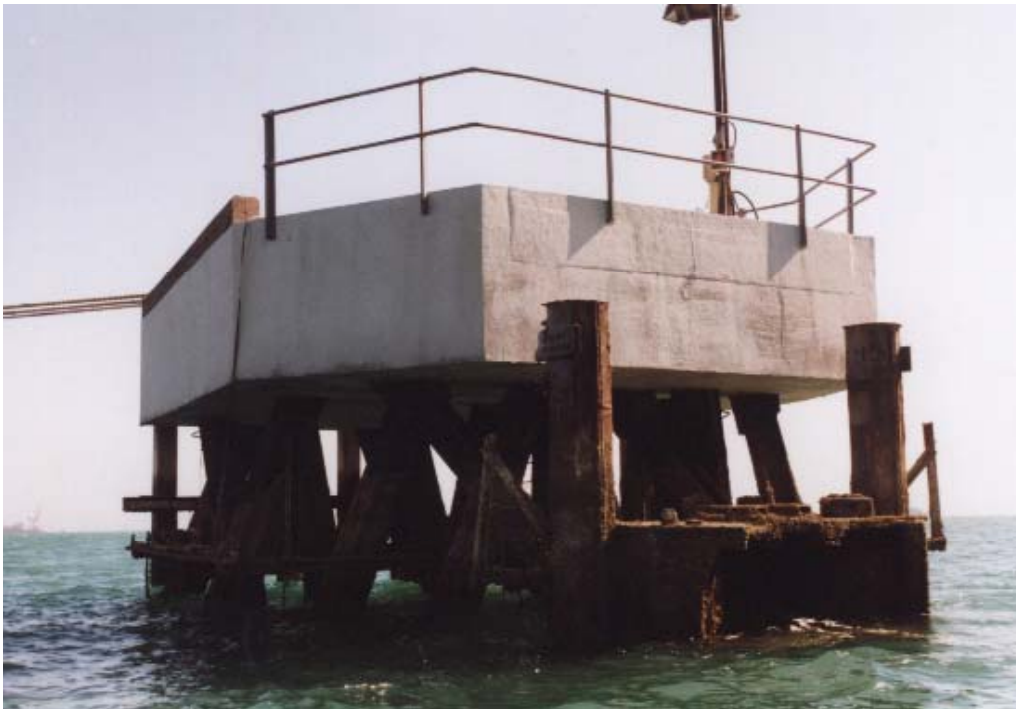
Figure 8: Construction en béton dans le golfe Arabique un an et demi après réparation (1999)
