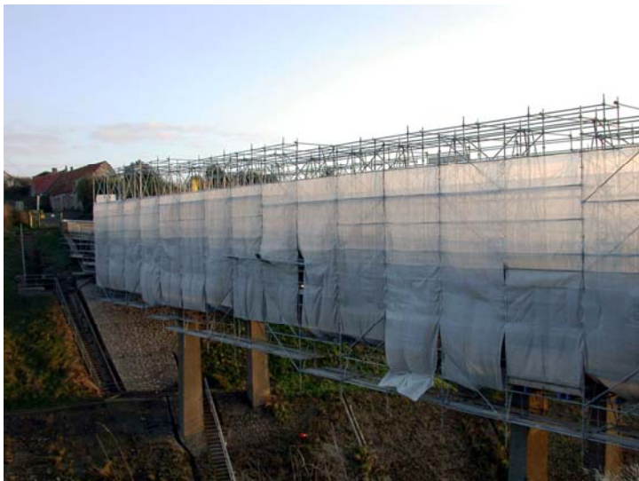
Foto: Grillo ( www.kks-beton.de )
