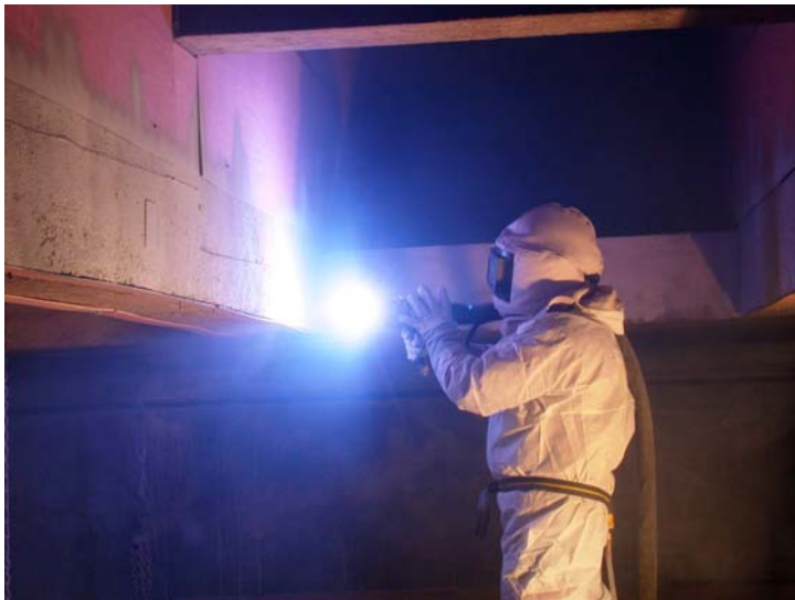
Foto: Grillo ( www.kks-beton.de )
