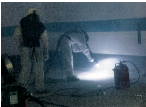
Abb. 3: Drahtlichtbogenspritzen eines Parkdecks
